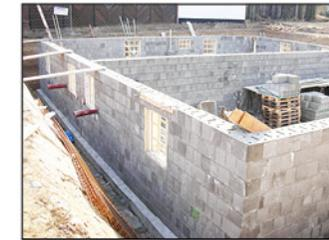
Ganz egal, ob Sie GEKA Phon, GEKA Therm oder GEKA Unilath als Keller- oder Mauersteine verwenden: Dank der Hohlblockbauweise wird die Arbeit enorm erleichtert. Die Hohlblockmaße sind selbst bei den größeren Formaten so gewählt, dass der Maurer durch das geringe Gewicht entlastet wird. Auf diese Weise kann unter ergonomischen Bedingungen ohne zusätzliche Anstrengungen eine Wand gesetzt und Mörtel eingespart werden.
